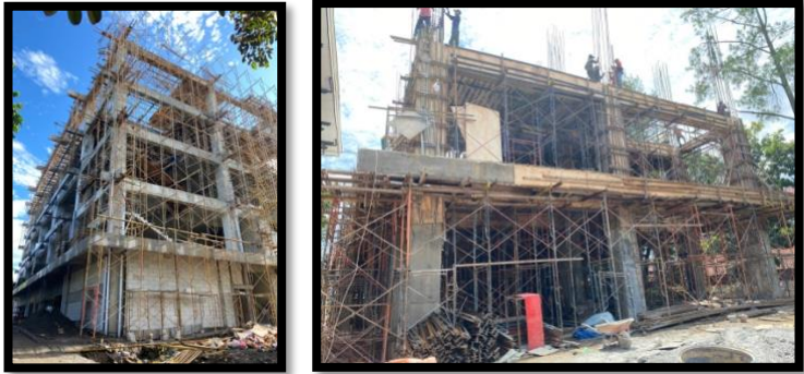
Gambar 1. Gedung Restek dan Gedung PTBB yang sedang dalam proses pembangunan
